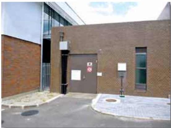
PCB 廃棄物保管場所
