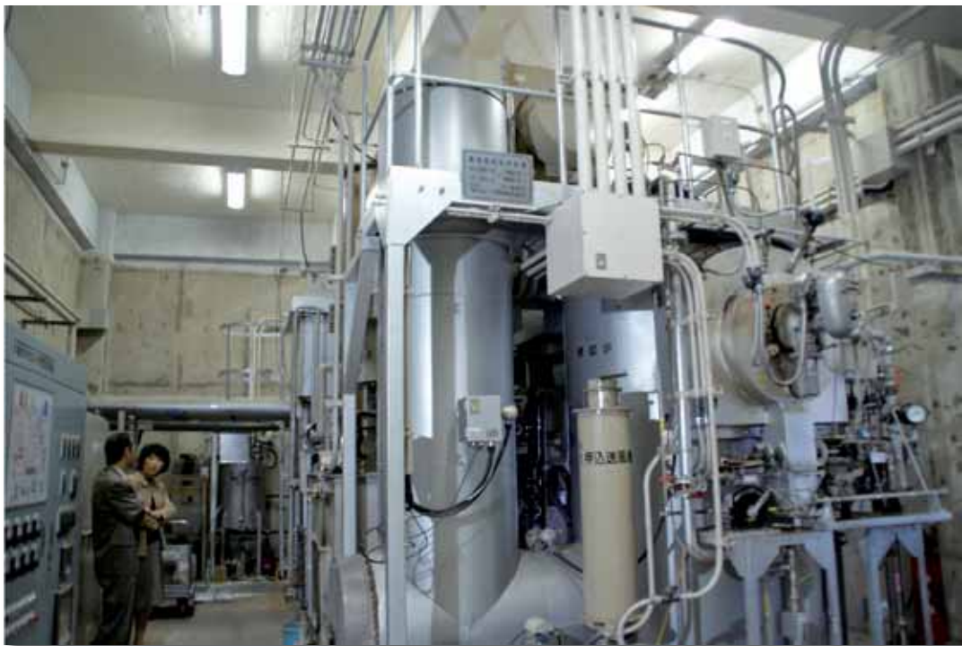
環境科学センター内での有機廃液焼却処理装置の説明
