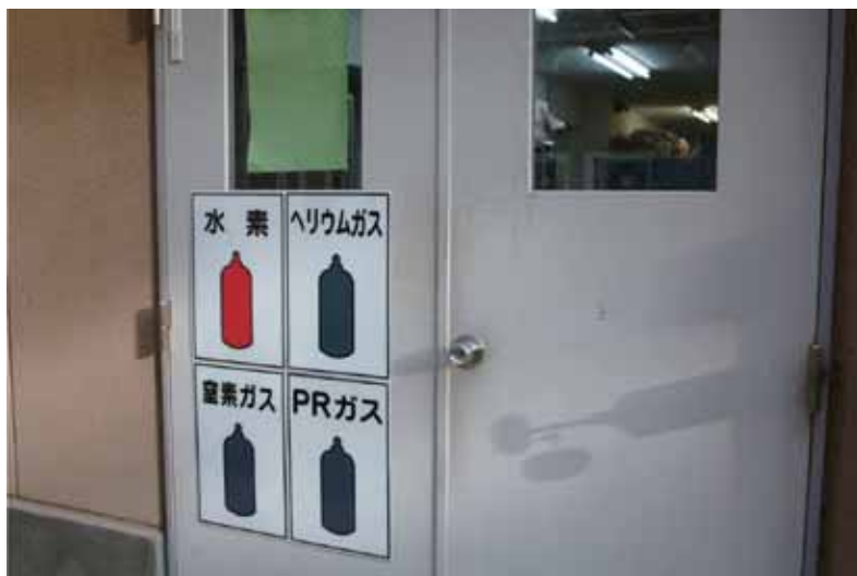
保管している高圧ガスの表示
