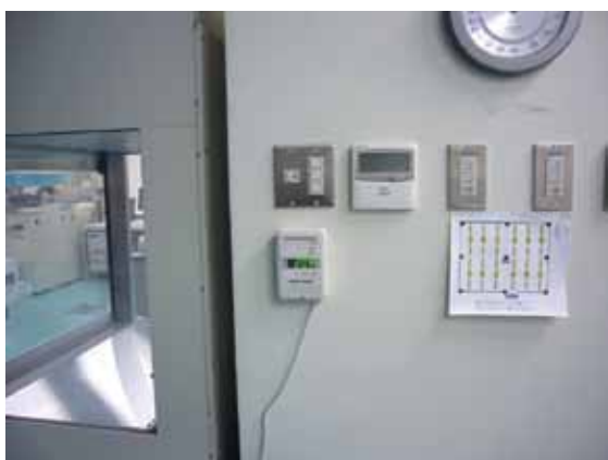
酸素濃度計の設置
