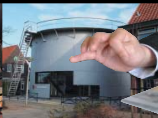
Gashouder 1927年に建設されたガスタックがオフィスに改修されたもの
